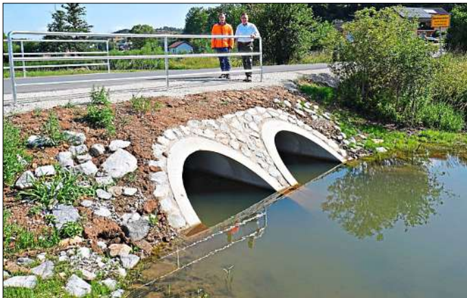
Julian Schamfuß vom Bauamt steht mit Velburgs Bürgermeister Christian Schmid auf der fertigen Zufahrtsstraße nach Oberwiesacker.
