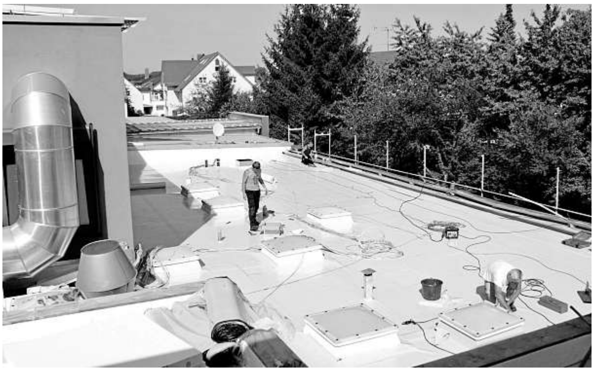
Derzeit wird in Seubersdorf die Hauptschule saniert. Davon profitieren jetzt auch die Grundschüler. Foto: Gabler
