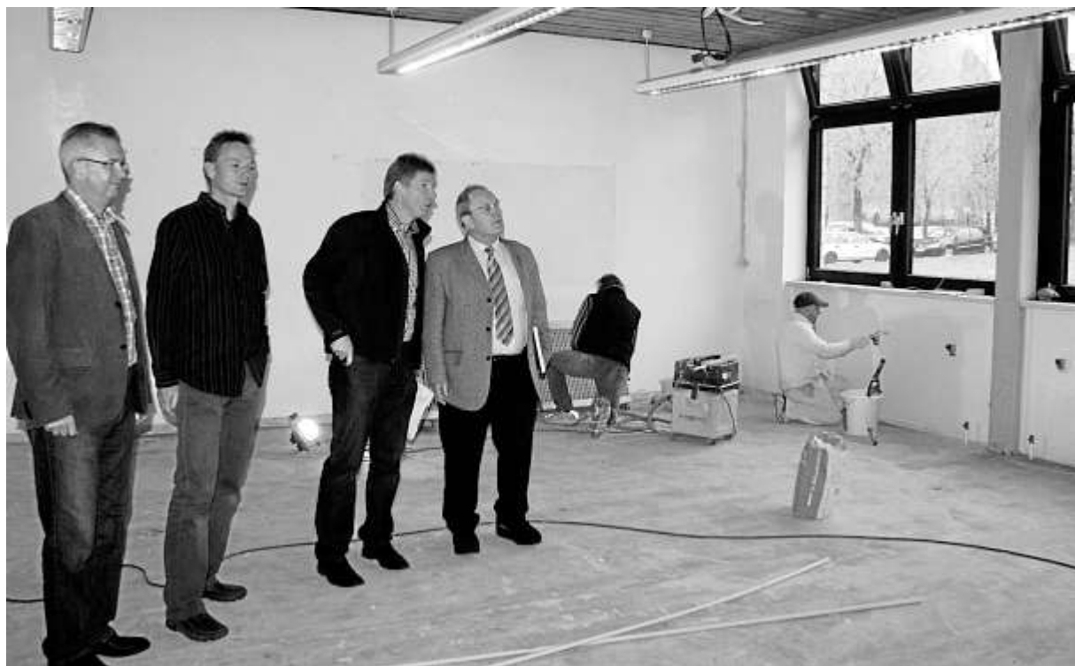
Statt Schülern sind derzeit Handwerker in den Klassenräumen, in die die Mitglieder der Gemeinde- und Schulverwaltung um Architekt Thomas Ruidl einen Blick warfen.
